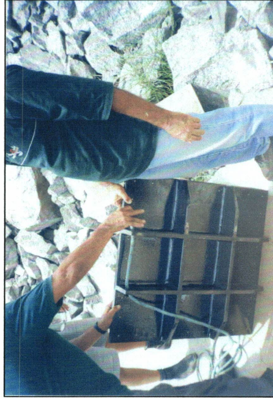
FOTO Nº 07 - Vista do "Stop-log".
