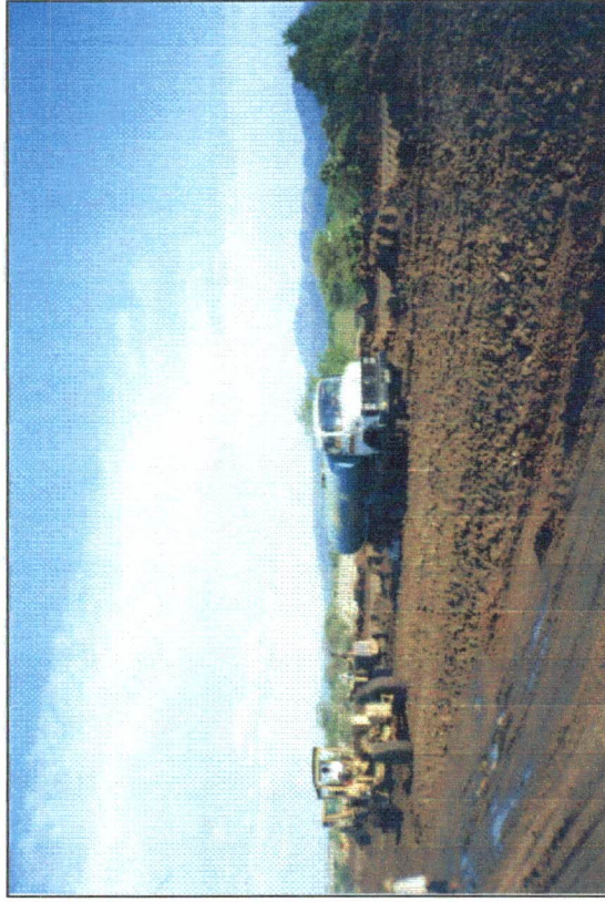
FOTO Nº 04 - Homogeneização do material, após umedecimento.
