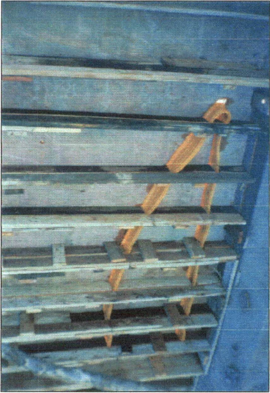
FOTO Nº 05 - Detalhe da junta fungeband.
