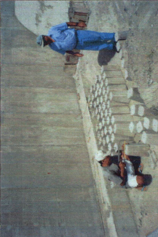
FOTO Nº 09 - Moldagem dos marcos topográficos.
