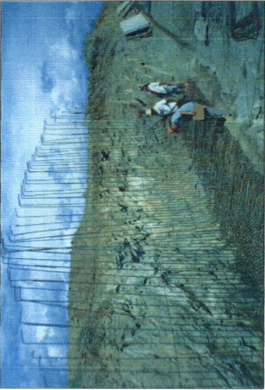
FOTO Nº 05 - Conferência da ferragem para arrumação final.
