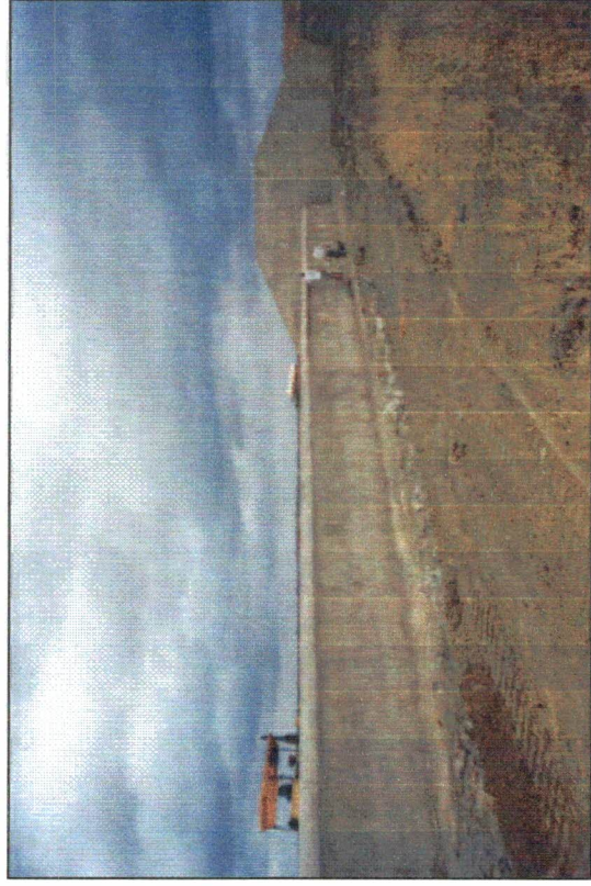
FOTO Nº 04 - Vista do perfil Creager, à montante.
