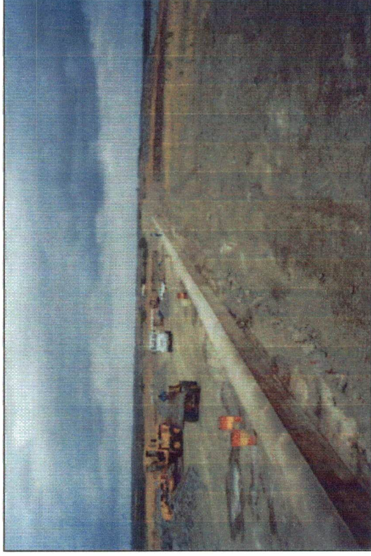
FOTO Nº 12 - Vista panorâmica do sangradouro, com o perfil creager concluído.
