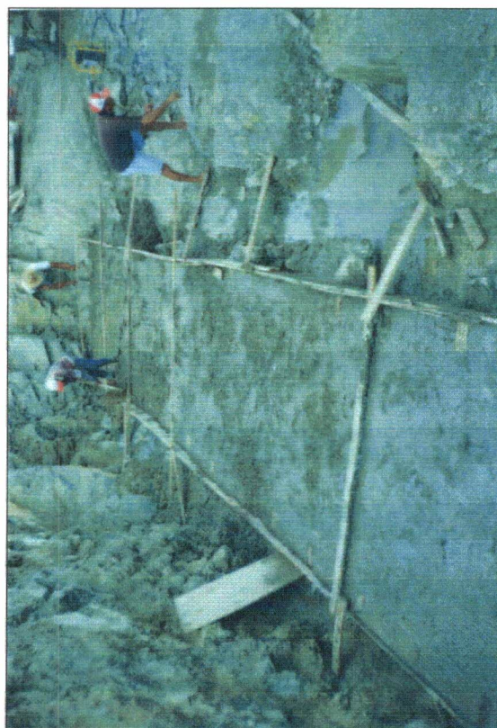
FOTO Nº 03 - Regularização final para colocação de ferragem do muro.
