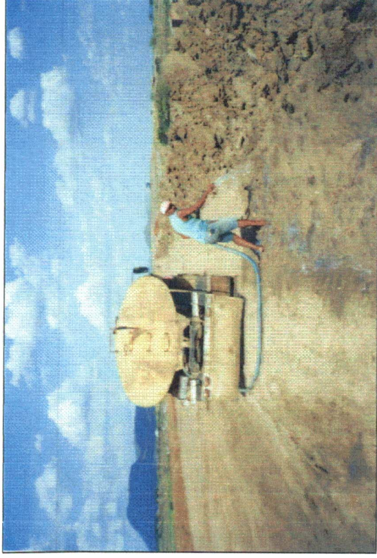
FOTO Nº 10 - Umedecimento do filtro vertical.
