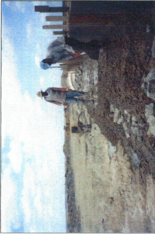
FOTO Nº 01 - Vibração do concreto ciclóptico do perfil creager.
