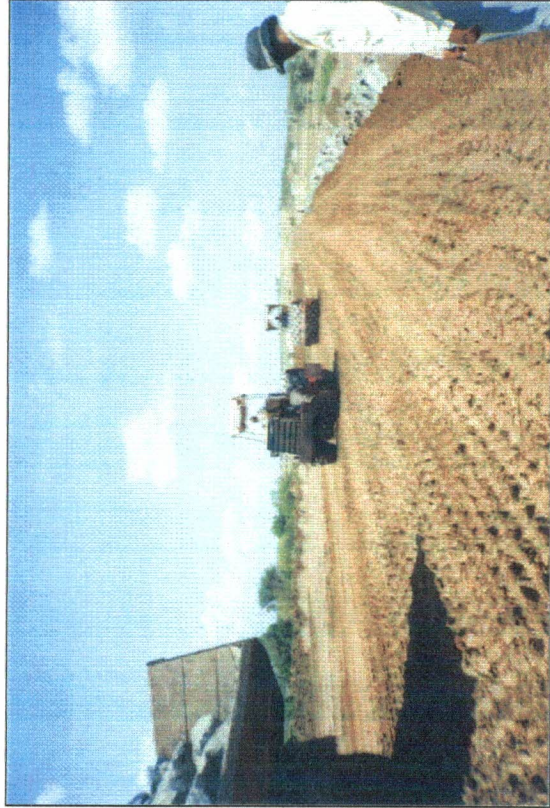
FOTO Nº 05 - Vista da construção do maciço com 3 atividades: - carradas alinhadas para homogeneização - homogeneização com umedecimento - compactação com rolos autopropelidos
