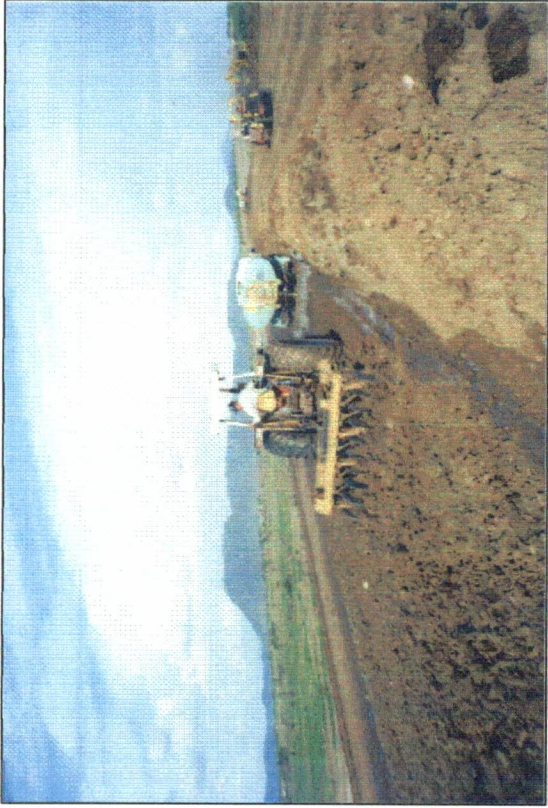
FOTO Nº 05 - Vista da construção do maciço com 3 atividades: - carradas alinhadas para homogeneização - homogeneização com umedecimento - compactação com rolos autopropelidos
