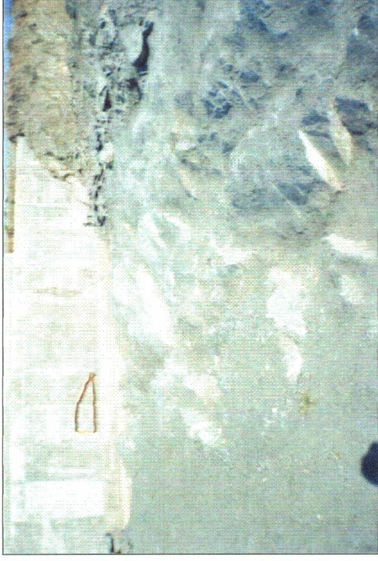
FOTO Nº 02 - Topo rochoso preparado para receber as fundações no sangradouro.
