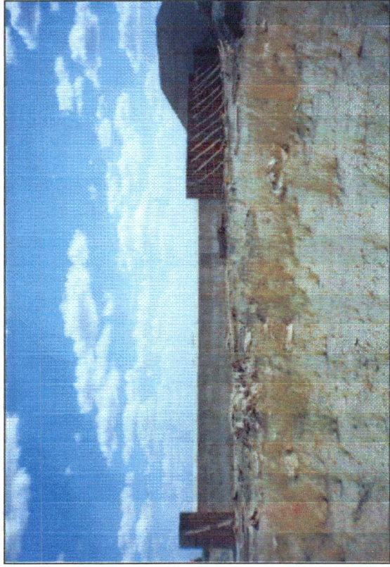
FOTO Nº 07 - Vista do perfil Creager à montante.
