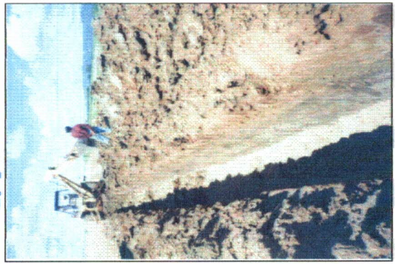
FOTO Nº 10 - Corte do filtro vertical (chaminé).
