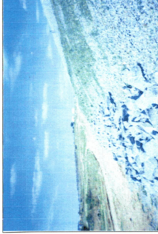
FOTO Nº 06 - Vista do maciço à jusante, mostrando as proteções do talude e o "filtro de pé" (rock fill).
