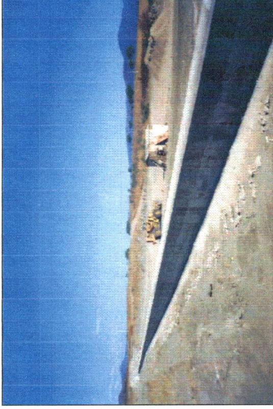
FOTO Nº 06 - Vista do perfil Creager, à montante.
