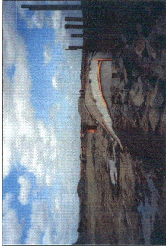
FOTO Nº 03 - Junta do perfil creager com "Fungeband" e isopor.
